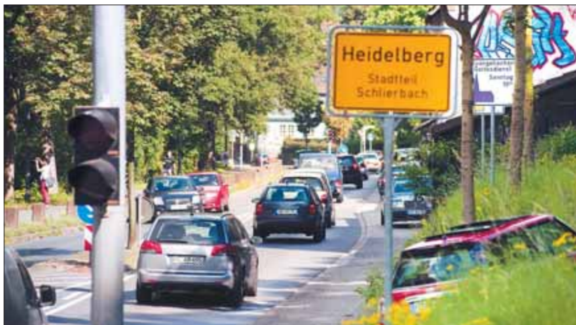
Heidelberg hat zurückgebaut: Bei der Einfahrt nach Schlierbach wird es eng. Foto: Stefan Kresin
